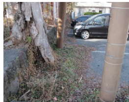
たて道40号内部の土留めの石垣
