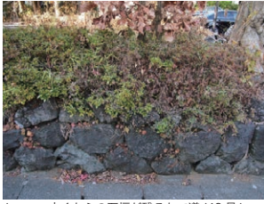
古くからの石垣が残るたて道（40号）
