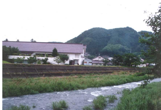
写真1 整備前の様子
