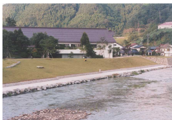
写真2 整備後の様子
