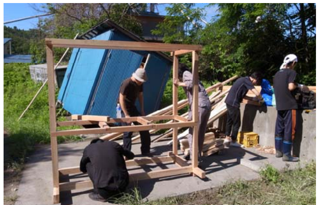
図-2 組み上げ作業の様子
